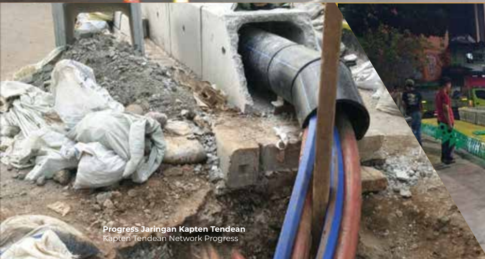
Progress Jaringan Jalan Kuningan Barat Jalan Kuningan Barat Network Progress
